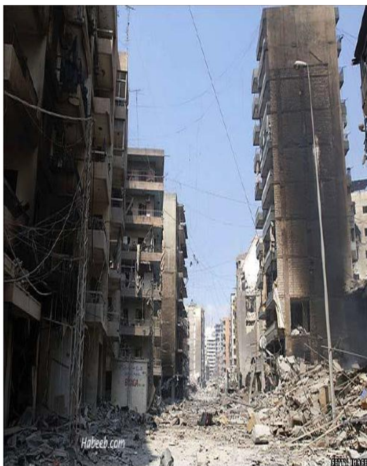
شکل ۶۹- تصویری از انسداد معابر با فروریزش ساختمان
