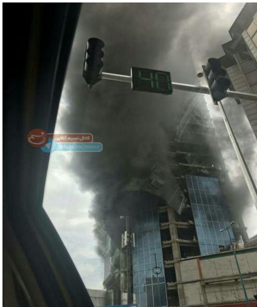
شکل ۲۵: ساختمان شکل «الف» در حال سوختن در مراحل ساخت
