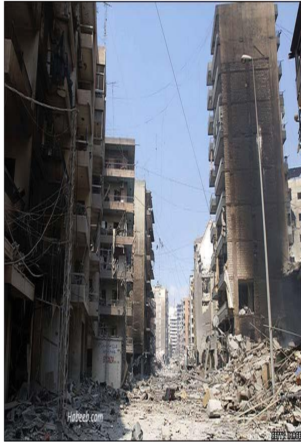
شکل ۲۶: تصویری از انسداد معابر با فروریزش ساختمان
