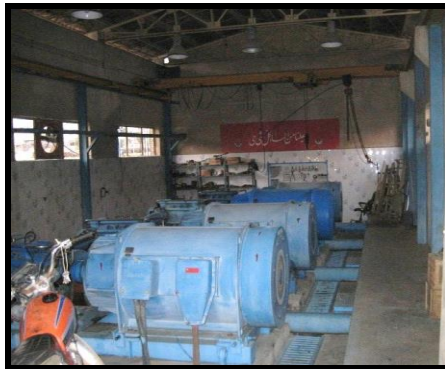
شکل ۱۲: نمایی از یک ایستگاه پمپاژ آب
