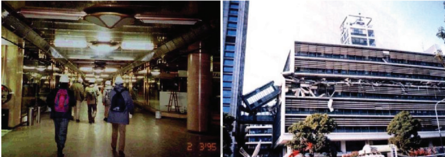
شکل ۶-۱۱- مقایسه آسیب وارده شده به ساختمان‌های روزمینی و زیرزمینی در زمین‌لرزه کوبه ژاپن
