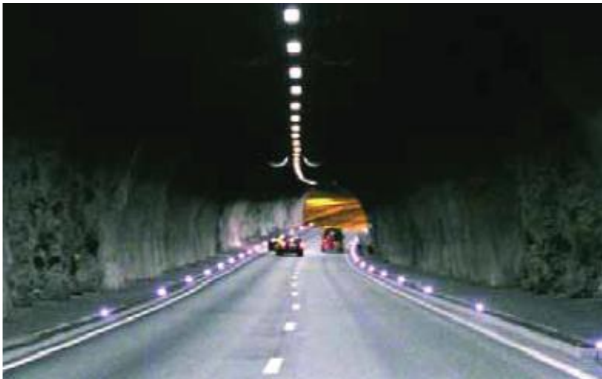
برخی تونل‌های اروپا از دیودهای (لامپ دوقطبی) ساطع کننده نور در فواصل مساوی استفاده می‌کنند تا به رانندگان در تشخیص کناره‌های راه و تعیین فواصل امن از جلو کمک نمایند.
