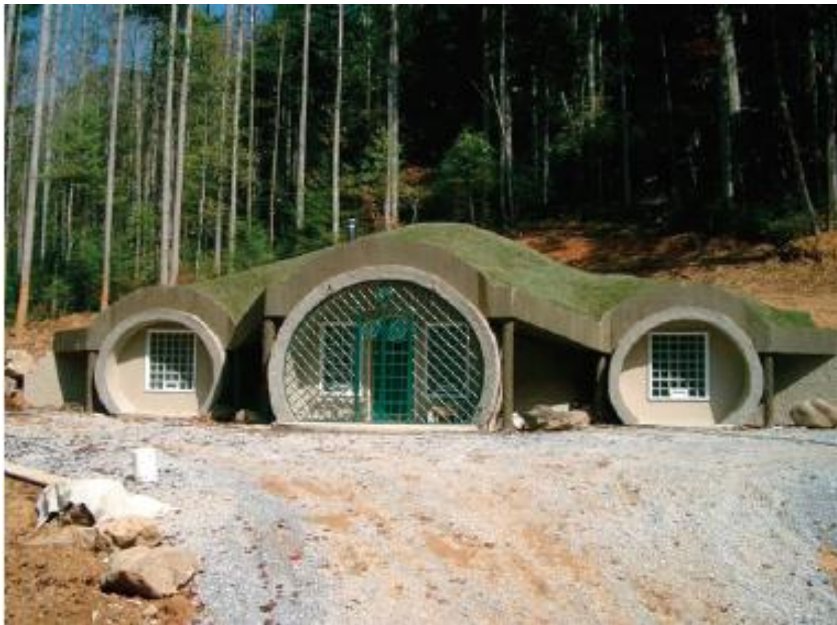
شکل ۴-۳ خانه زمین - پناه تا حدی زیرزمینی است که مقاومت بیشتر و بهره‌وری انرژی بیشتری را ارائه می‌دهد.
