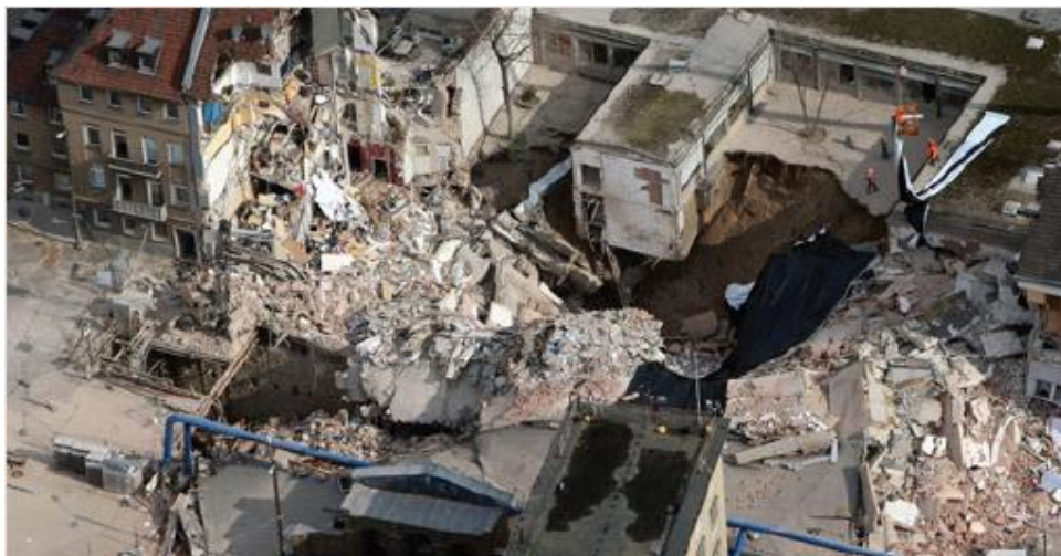
ریزش ساختمان‌های متعدد که از ریزش حفاری ناشی شده است.
