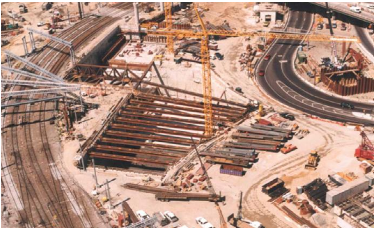
شکل ۶۶ حفاری مهار بندی شده برای قسمت تونل رو باز شاهراه مرکزی بوستون.
