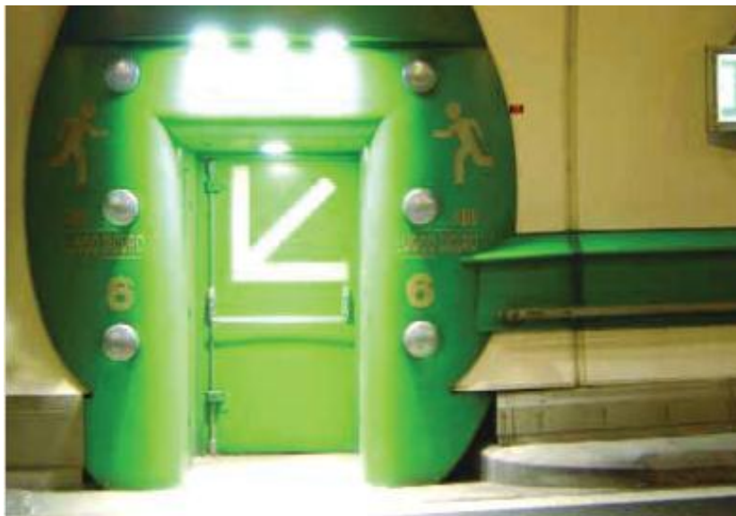
مثالی از علامت مسیر فرار تونل بلان مون (مایین فرانسه و ایتالیا)، نمونه‌ای از علائم یکسان مورد استفاده در بسیاری از کشورهای اروپایی.
