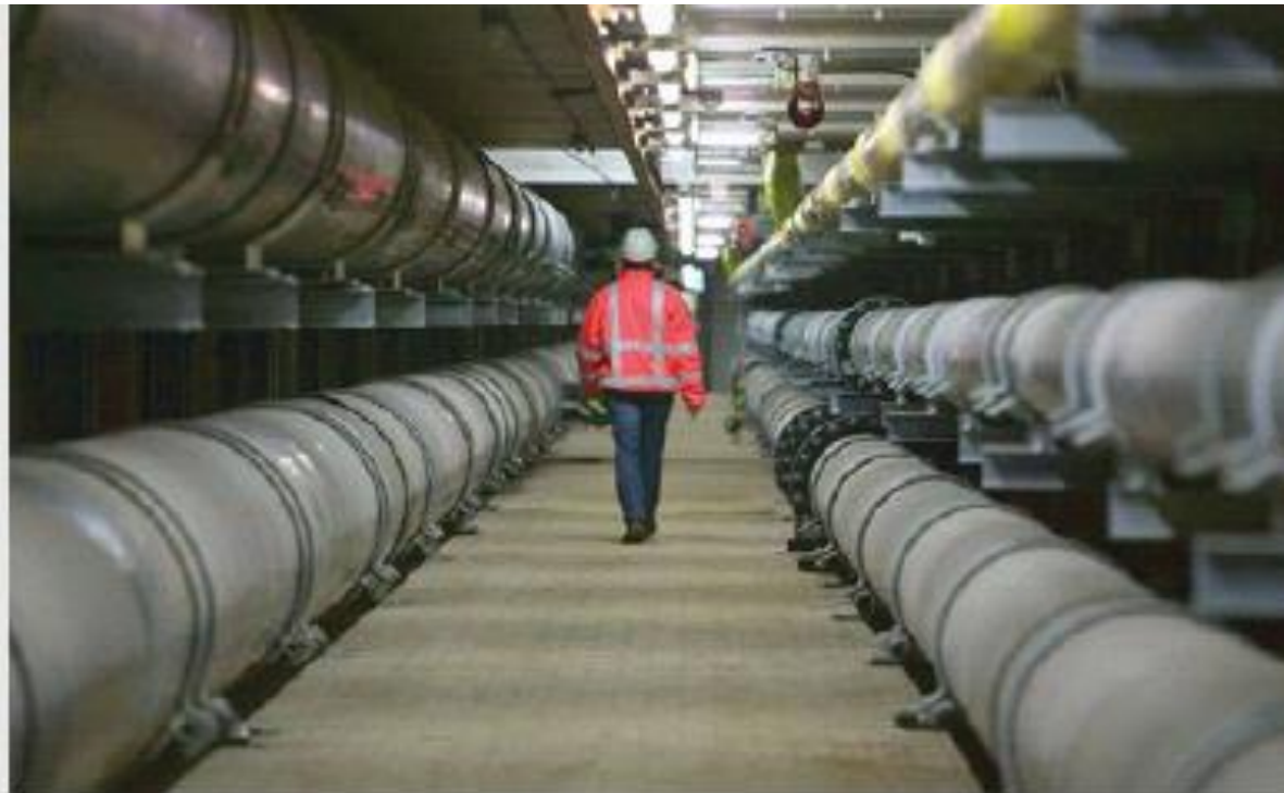
شکل ۱-۶ نمونه‌ای از یک راهرو تأسیساتی در آمستردام که می‌تواند خطوط تأسیساتی مختلفی مانند برق، آب و فاضلاب، و ارتباطات را حمل نماید.
