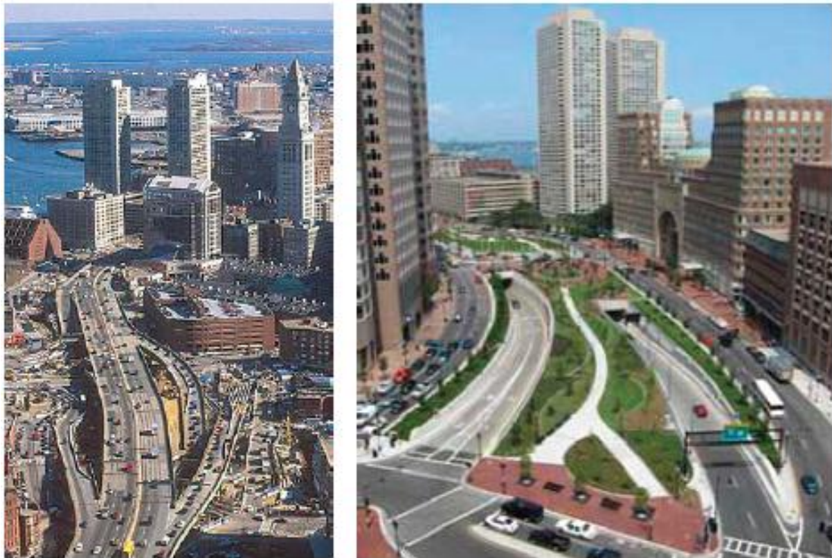
شکل ۵-۲ شاهراه مرکزی بوستون به صورت یک سازه هوایی و یک سواره رو زیرزمینی
