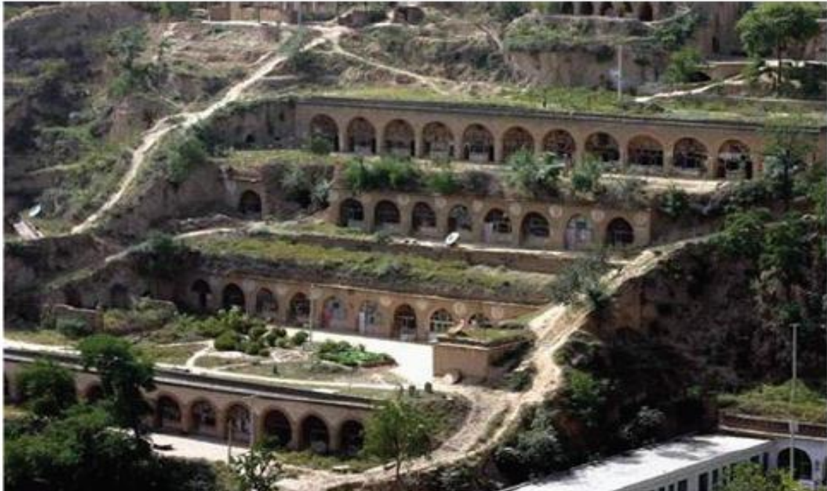
شکل ۱-۱ نمونه‌ای از یک یائو دونگ چند طبقه، نوعی از غار خانه‌های کنده شده در دیوارهای عمودی یا تقریباً عمودی بادرفت (خاک سیلتی). در استان شآنشی در شمال غربی چین. تقریباً ۹۰ درصد ساکنان روستایی منطقه در یائو دونگ زندگی می‌کنند.
