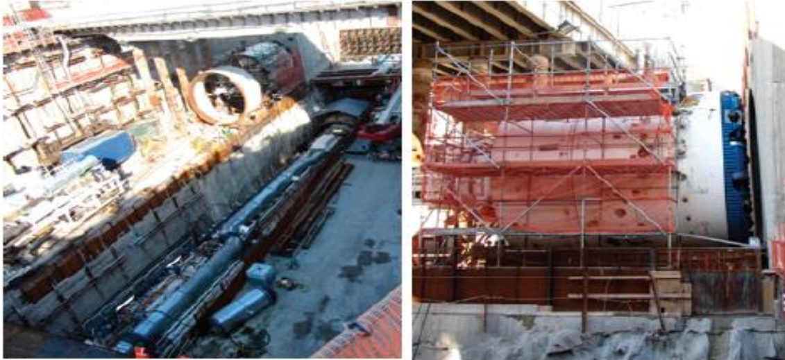
شکل ۶-۷ ماشین آلات سپر گل روان (دوغاب) برای پروژه دسترسی سمت شرقی، کوئینز، نیو یورک. (تصویر سمت چپ) مونتاژ دو ماشین گمانه‌زنی تونل‌سازی (TBM) و چرخ دانه عقبی آنها در گودال راه‌اندازی. (تصویر سمت راست) تصویر نزدیک از سرفرز TBM.
