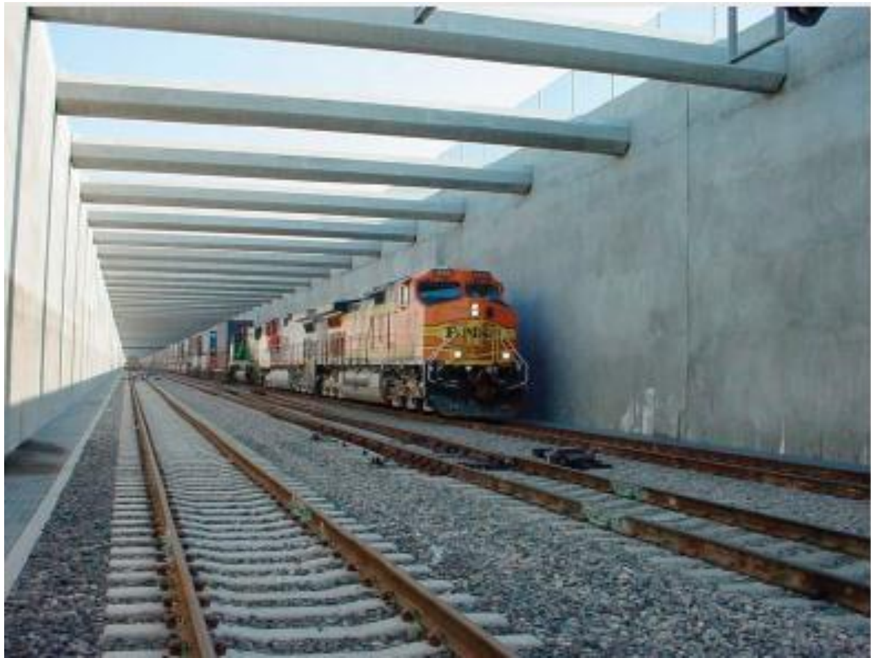
یک قطار کانتینری در خط باربری کریدور آلامدا در کالیفرنیا. قطارها در یک خندق مهارشده رو باز که تهویه موتورها و غیر همسطح‌سازی رفت و آمد کانتینری را فراهم می‌سازد حرکت می‌کنند.
