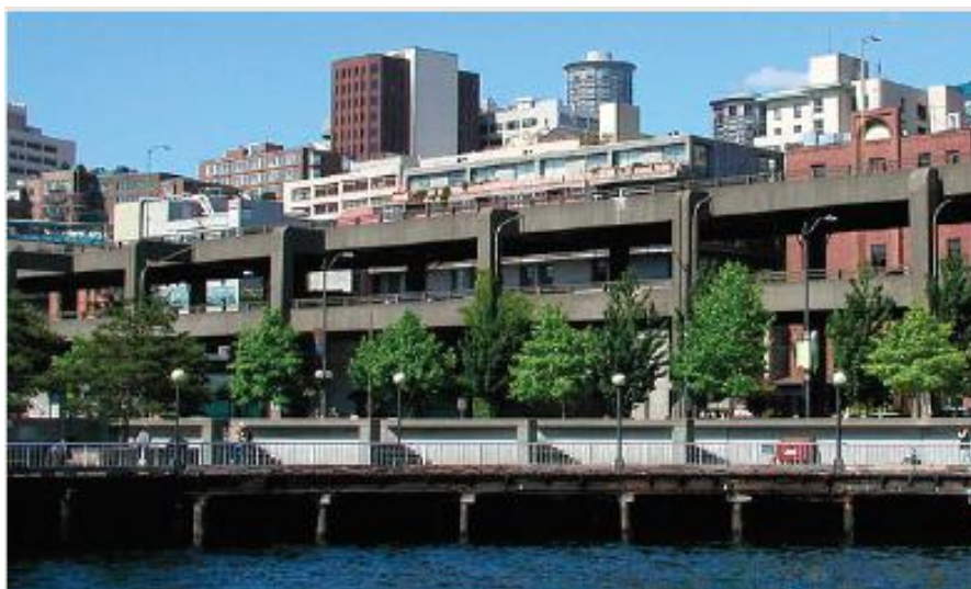
پل روگذر آلاسکا در سیاتل واشنگتن، یک تند راه دو طبقه در امتداد اسکله شهر می‌باشد.
